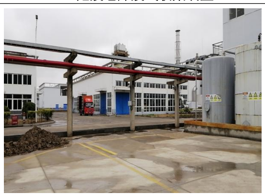
403 危废仓库外监控
