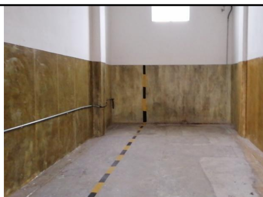
210 危废仓库地面防渗
