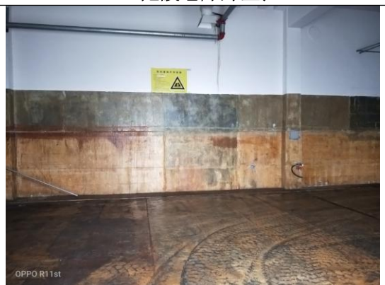
403 危废仓库地面防渗
